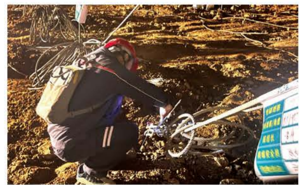
日照疏港牵引站110千伏外部供电工程覆陆-疏港牵引站110kV线路段全长15.3km，为避开历史文物遗址，
